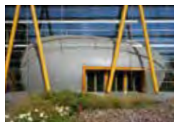
Administratiegebouw WeberHaus, Rheinau/Linx, D Dipl.-Ing. Günter Hermann, Stuttgart Wittenauer GmbH, Sasbach TECU® Zinn
