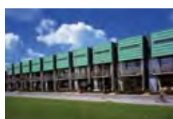
Wooncentrum, Purmerend, NL Roy Gelders Architecten, Amsterdam Ridder Dak- en Wandsystemen BV, Hoorn TECU® Patina
