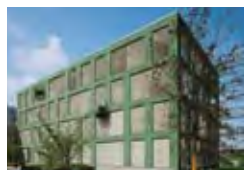
InnovationsCampus van de Wolfsburg AG, Wolfsburg, D O.M. Architekten BDA, Braunschweig Bisping GmbH & Co., Munster TECU® Patina_mesh
