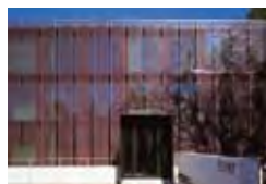
Kantoorgebouw van de International Ice Hockey Federation, Zürich, CH Tilla Theus und Partner AG, Zürich Scherrer Söhne AG, Zürich TECU® Classic_flatmesh
