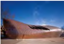
Poppodium Mezz, Breda, NL (EEA) Erick van Egeraat associated architects, Rotterdam SV Metaaldak Specialist BV, Beek en Donk / Brouwers Zink BV, Maasmechelen TECU® Classic
