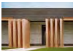
Cimitero Trescore, I Ing. Augusto Zambelli, Trescore Balneario (BG); Arch. Basilia Barcella, Bergamo EFFEGI Costruzioni S.r.l., Castelli Calepio (BG) TECU® Bronze
