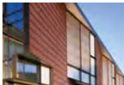
Productie- en kantoorgebouw, Baar, CH Burkart, Bauabteilung Baar; Barkow Leibinger Architekten, Berlin Gebr. Baur AG, Baar TECU® Oxid
