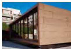
BTV Bank, Innsbruck, A Hanno Vogl-Fernheim, Innsbruck Spenglerei & Glaserei Anker, Hall TECU® Bronze_mesh
