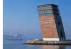
Haven-verkeerstoren, Lissabon, P Gonçalo Byrne, G.B. Arquitectos, Lissabon Zn-Revestimentos de Zinco Lda., Maia TECU® Classic
