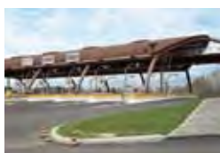
Motorway Toll Collection Area, Lucca, I Ettore Piras Architetto, Genova Trenkwald S.r.l., Ovada (AL) TECU® Oxid
