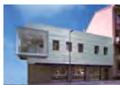
Japan Restaurant „My Sushi“, Milaan, I Studio di Architettura Clerici, Gallizia Tutucci, Milaan Copermont S.r.l., Clusone (BG) TECU® Zinn
