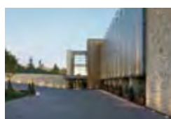
Hotel Spa Castillo de Gorraiz, Gorraiz, E Arquitectos Asociados, Navarra, E TECU® Gold/Stainless_weave
