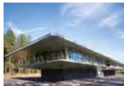
Verkeersleidingscentrum Noord- en Oost-Nederland (VCNON), Wolfheze, NL De Architecten Cie, Amsterdam Verkoelen Dakbedekkingen BV, Beegden TECU® Zinn
